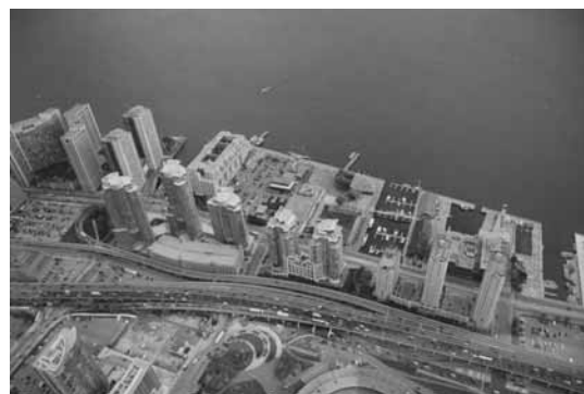
上空から見た再開発地区
