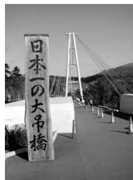
九重“夢”大吊橋入口
