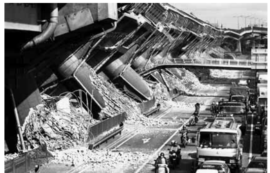
写真④ 倒壊した阪神高速道路（1995年1月17日）
