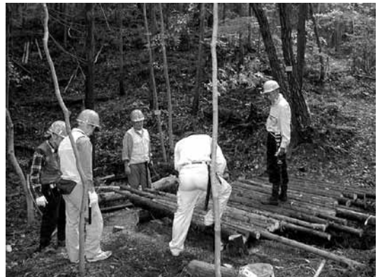
山道に橋を掛ける作業
