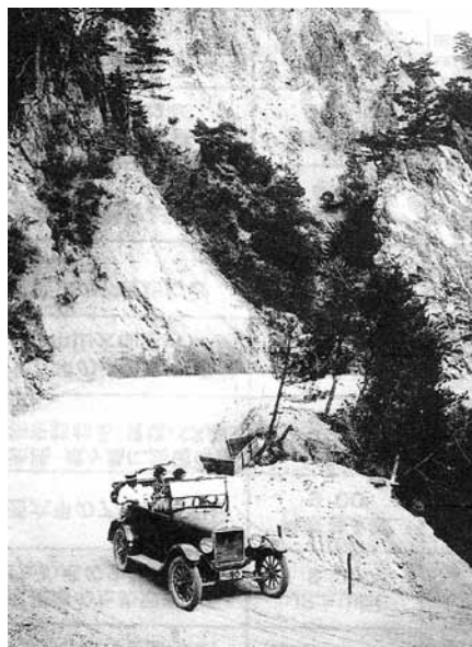
写真-3 建設された自動車道路(昭和初期) 6)
