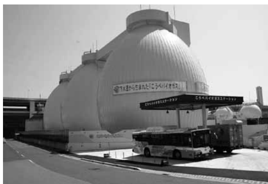
写真6 こうべバイオガスステーション (東灘処理場内)
