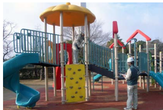
公園施設の安全点検
