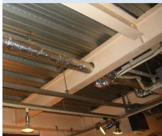
鉄骨は火災の熱で耐力が低下するため、断熱性能のある材料で覆わなければなりません。
