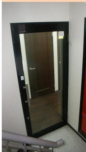
階段室と各階の部屋との間の扉は、**防火設備**（常時閉鎖式もしくは煙感知器連動式）としなければなりません。
