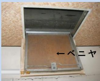
※100㎡以下の部屋は、内装材を不燃材料とすることで、**排煙設備の設置が緩和**されていることがあります。この場合、不燃性能が無い内装材に変更すると違法となります。
