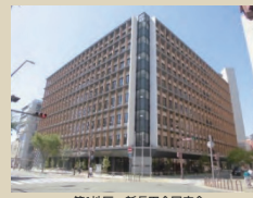
第1地区 新長田合同庁舎
