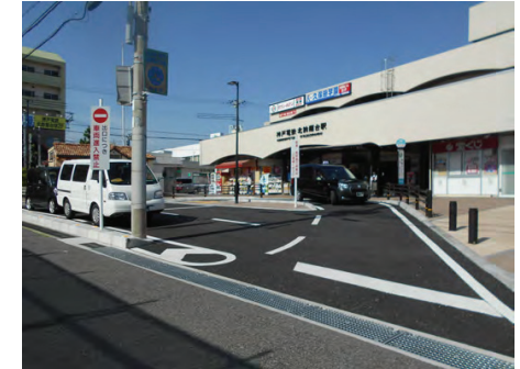
北鈴蘭台駅西側ロータリー新設(神戸電鉄による整備)
